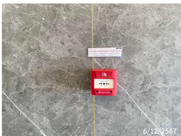
อุปกรณ์แจ้งเตือนเหตุฉุกเฉิน (Manual Call Points)
