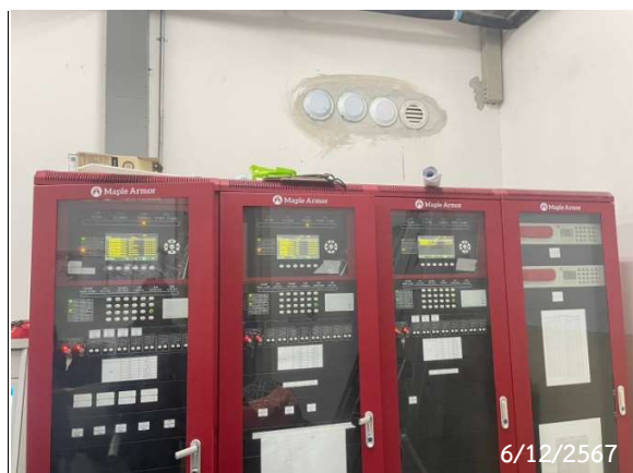
ตู้ควบคุมระบบสัญญาณแจ้งเหตุเพลิงไหม้ (Fire Alarm Control Panel)
