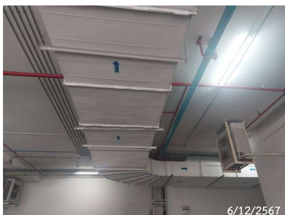
รูปที่ 2-48 ระบบระบายอากาศจากชั้นจอดรถ
