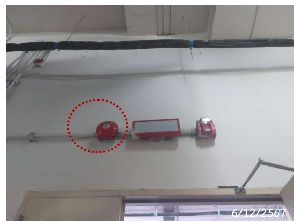
กริ่งแจ้งเตือนเพลิงไหม้ (Alarm Bell)
