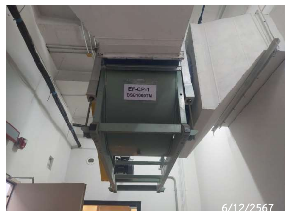
รูปที่ 2-48 ระบบระบายอากาศจากชั้นจอดรถ
