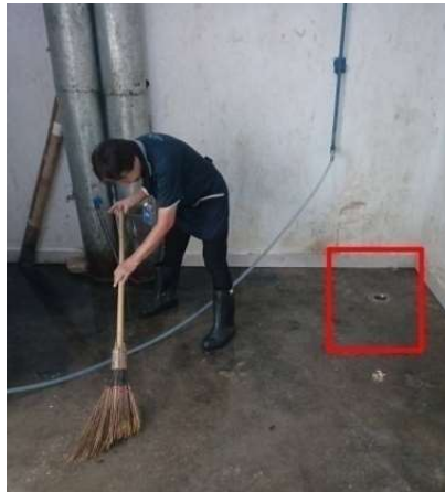
รูปที่ 2-20 ท่อรวบรวมน้ำจากการล้างห้องพัสดุฝอยรวม
